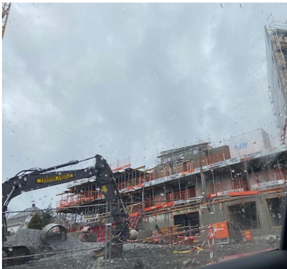
Bilde 2. Byggeprosjekt på S5, pr februar 2020
